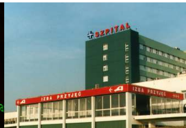
Znaki przestrzenne na konstrukcji stalowej, podświetlane światłem wewnętrznym + plafony (opaski) wielkogabarytowe.
