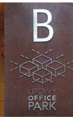
Panele podświetlane, Aluminium, stal, poliwęglan. Kamień i stal nierdz.
