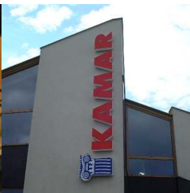
Znaki przestrzenne, front z plexi, montaż na dystansie bezpośrednio do elewacji.
