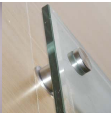
Detal mocowania stalowy:
