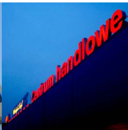
Znaki przestrzenne na konstrukcji stalowej, podświetlane światłem wewnętrznym.
