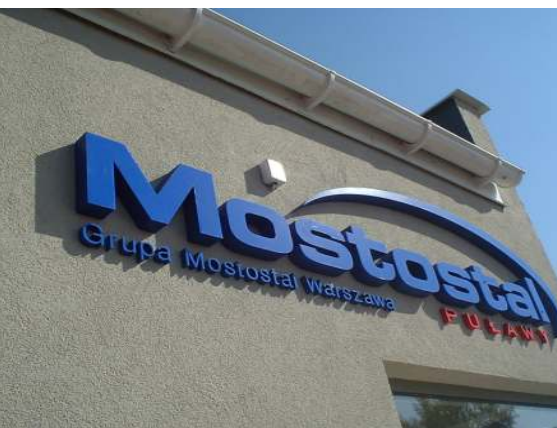
Znaki przestrzenne aluminiowe, front z plexi, montaż bezpośrednio do elewacji.
