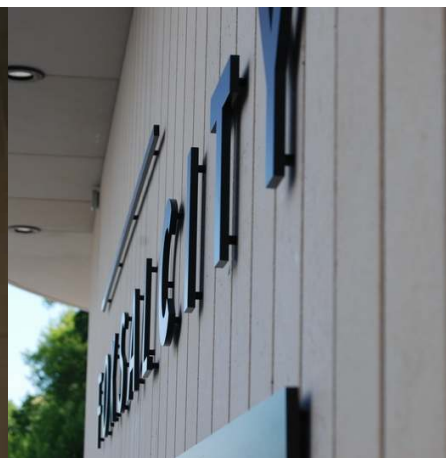
Znaki z aluminium na kamieniu Montaż na dystansach
