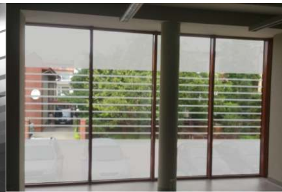
Przeszklenia budynku firmowego. Grafika wydziela przestrzeń pracy.
