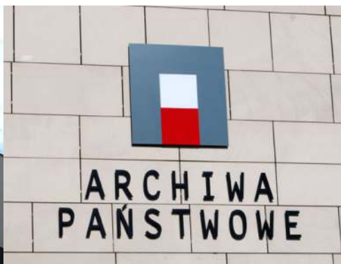
Znaki półprzestrzenne aluminiowe, na dystansach, montaż do piaskowca.
