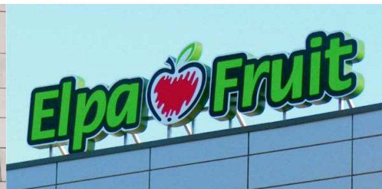
Znaki przestrzenne na konstrukcji stalowej, podświetlane światłem wewnętrznym.
