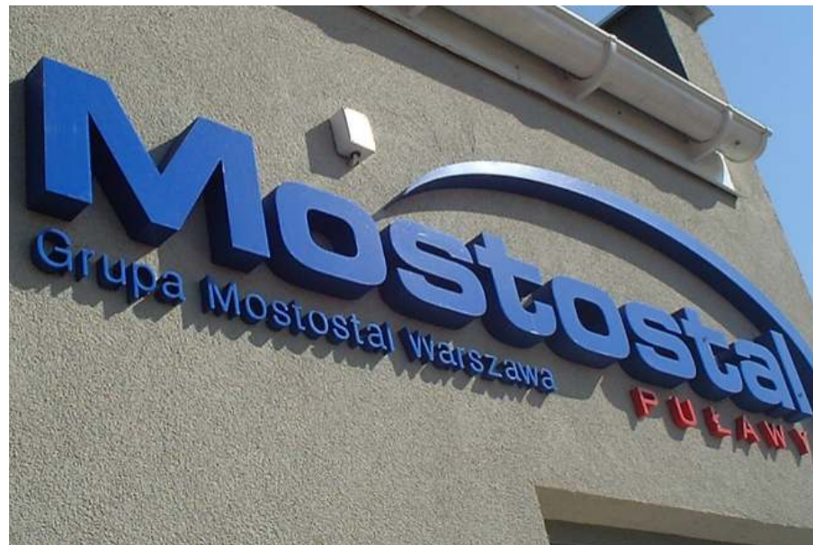
Mostostal - Znak na elewacji styrodur + plexi klejone do tynku
