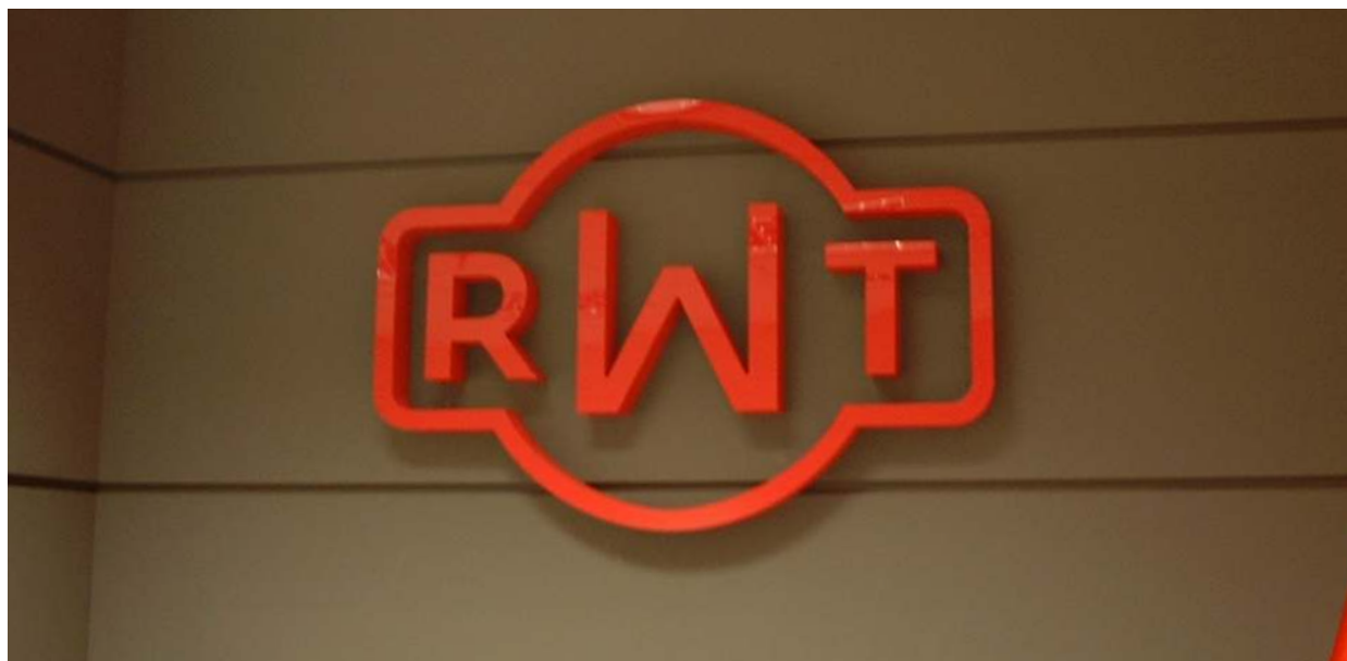
RWT - Znaki styrodur + akryl - klejone do elewacji tynkowanej
