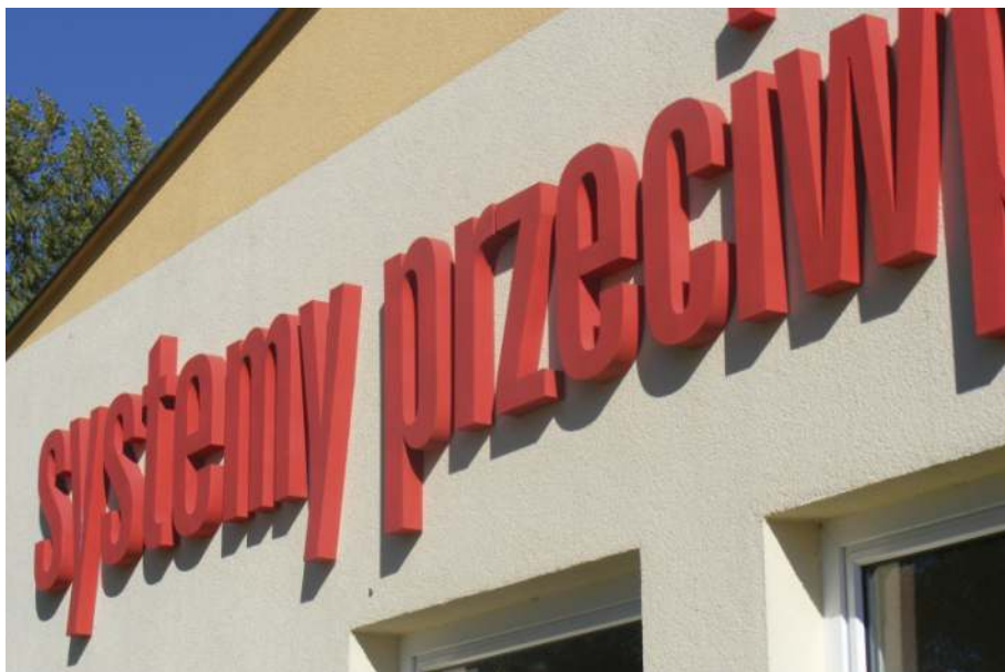
Polpoż - Znaki styrodur + akryl - klejone do elewacji tynkowej
